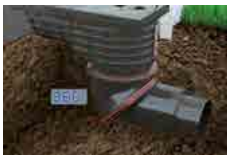
4. Отрегулируйте направление и угол установки выпускного патрубка
