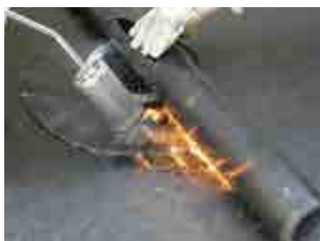
4. Наклеить 2-й слой гидроизоляции (до обжимного фланца)
