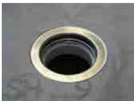
10. Зажать фильтрующий слой фиксирующим фланцем элемента HL350.0
