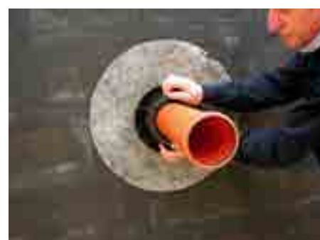
6. Затянуть фиксирующую гайку
